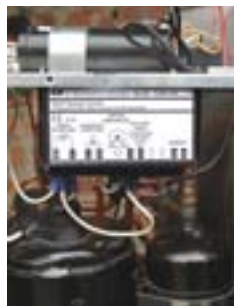
Таким образом устанавливается замедлитель
