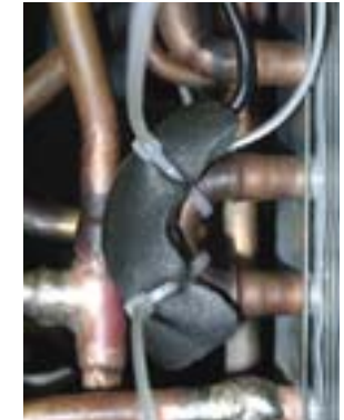
Фото 5. Дополнительная теплоизоляция повышает точность показаний сенсора
