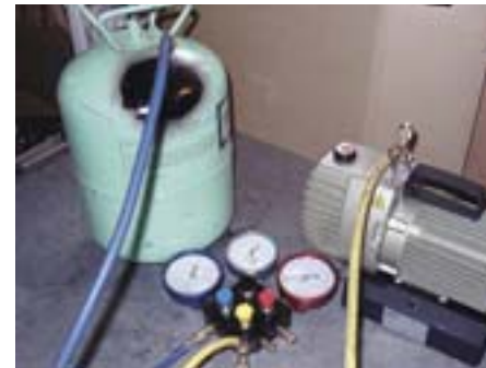
Вакуумирование баллона вакуумным насосом фирмы «REFCO» через манометрический коллектор
