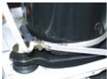
Установленный картерный нагреватель
