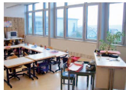
Школа в Вальдбурге: установка M-WRG-устройств под подоконником
